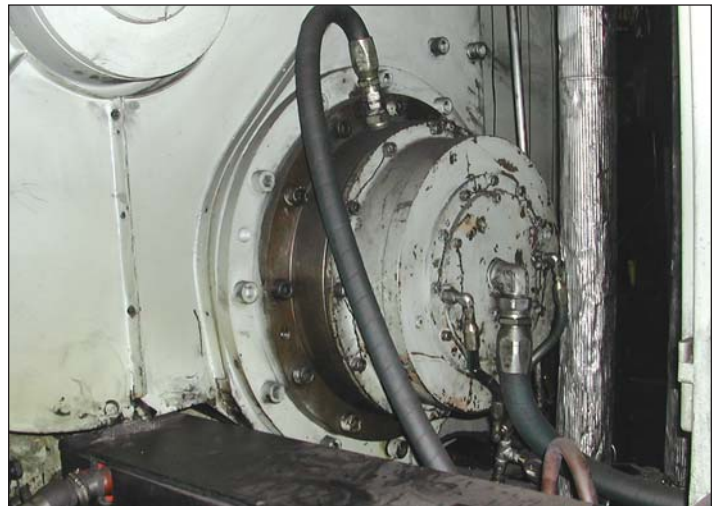
Press Pac® 2222 Brake National* 500 Ton Forging Press Installation
